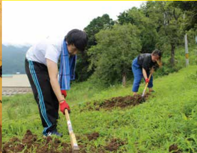
岩手県大船渡市泊地区 「結の道」という遊歩道の整備
